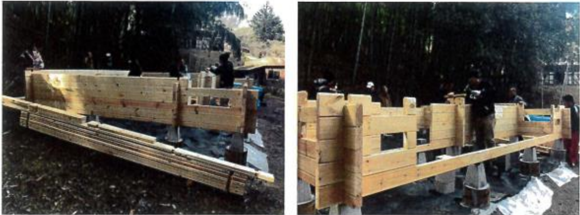
2020/04/19 組立状況 その①
