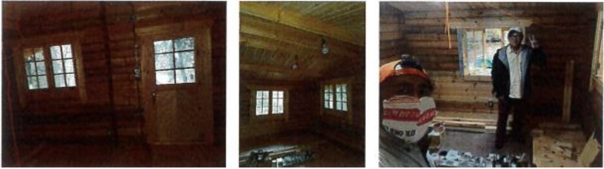
2021/04/11 外構・デッキ廻り・キシラ塗布状況
