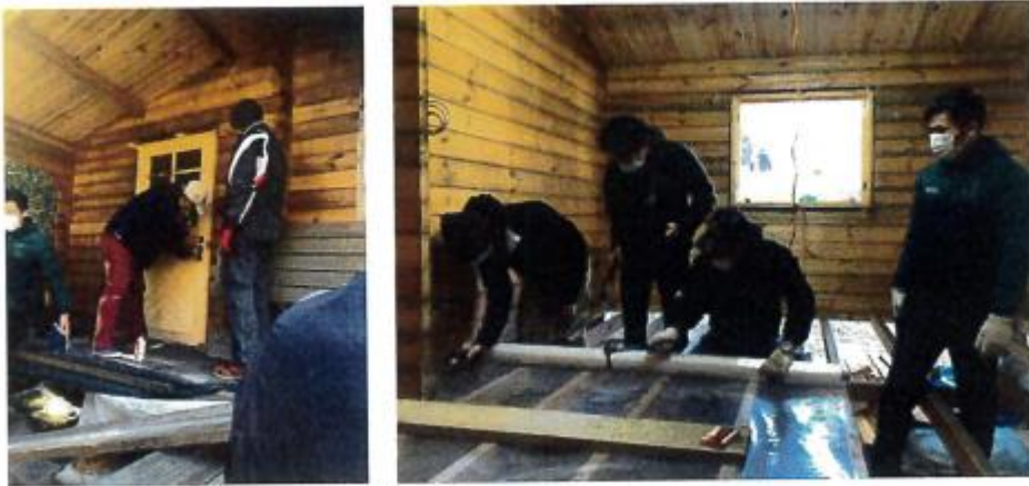
2021/01/10 外構・ドア・床下防湿断熱状況 その②
