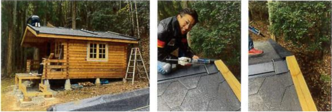
2021/01/10 外構・ドア・床下防湿断熱状況 その①
