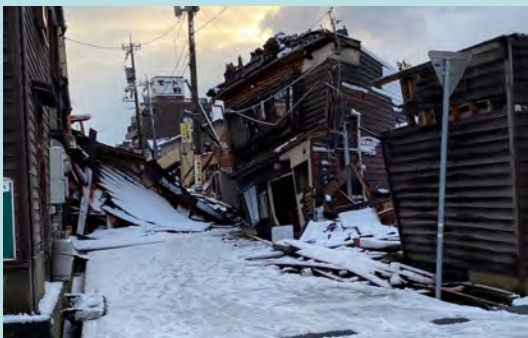
輪島市内倒壊した家屋の一部
