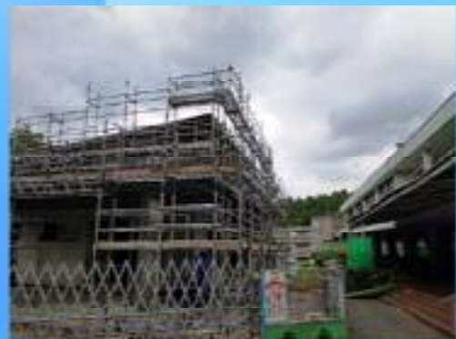
着々と建設の進む 東山荘新本館
