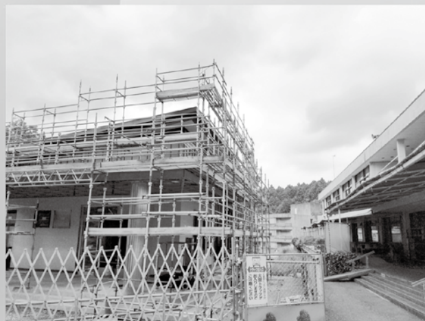
着々と建設の進む東山荘新本館
